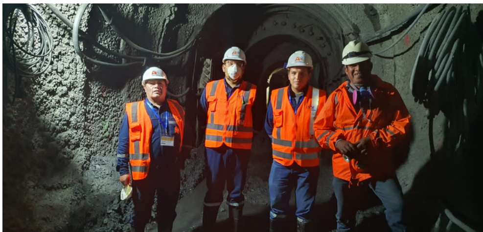
Foto AETN: Inspección a la construcción del Proyecto Túnel Secundario de la central Hidroeléctrica San José 1
